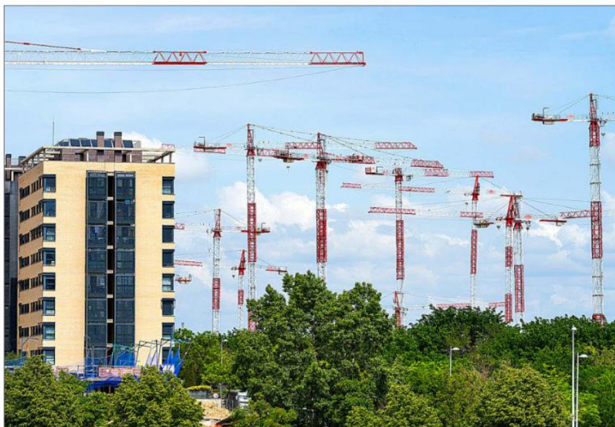
Panorámica de los trabajos de construcción de viviendas en Valdebebas, en la Comunidad de Madrid. ÁNGEL NAVARRIETE / EL MUNDO
