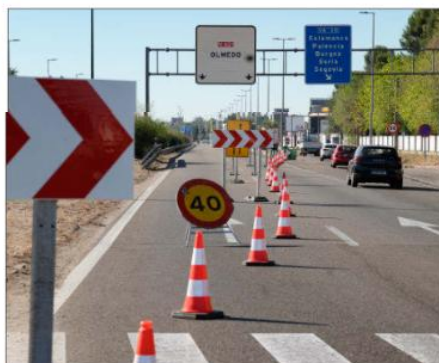
Modificaciones en el tráfico por la obra del viaducto de Los Tramosos
