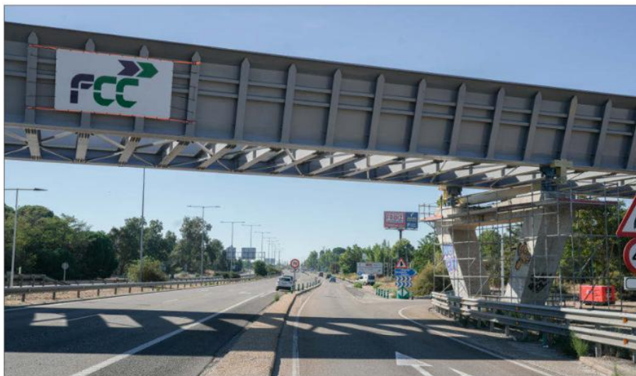
Avance de las obras del viaducto de Los Tramosos que sobrevuela ya la Nacional 601. REPORTAJE FOTOGRÁFICO DE JUAN GARCÍA.
