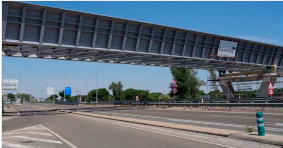
El viaducto de Los Tramosos sobrepasa ya la carretera N-601. E.M.
