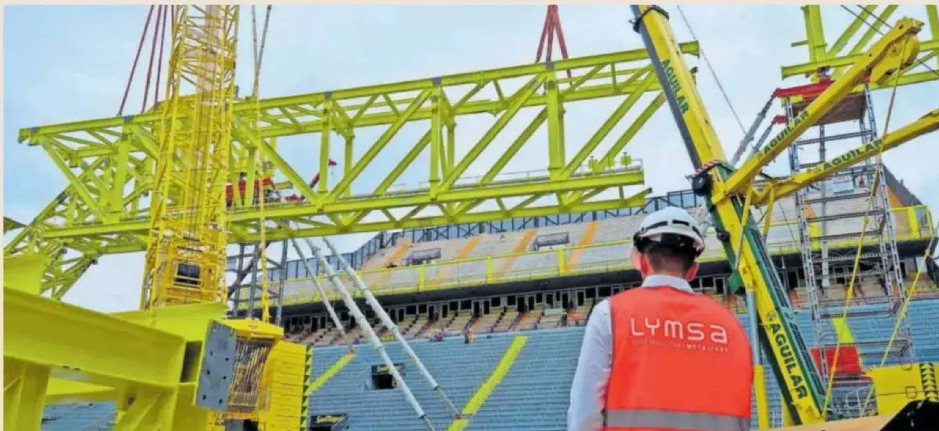
Un trabajador de Lymsa coloca una estructura metálica en el Estadio de la Cerámica en Villarreal, Valencia. CEDIDA POR LA EMPRESA
