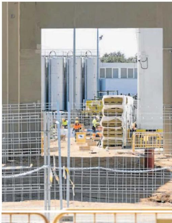
Operarios y material de obra en la fábrica de Iveco, que está en proceso de ampliación y modernización. A. MENGUEZA
