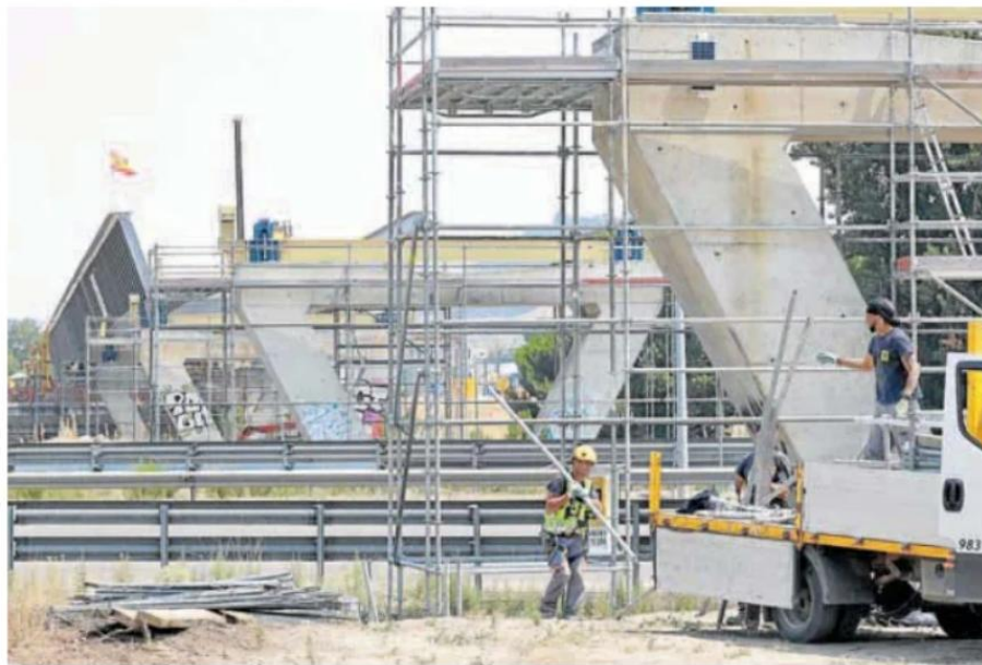
Obras de construcción del viaducto de los Tramosos, ayer martes. CARLOS ESPESO
