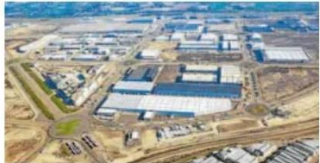
Imagen del polígono Plaza, junto al aeropuerto de Zaragoza. EL NORTE
