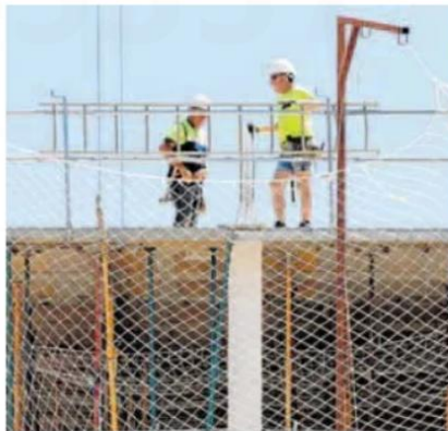
Dos trabajadores en una obra en el nuevo barrio de Cuarteles. ALBERTO MINGUEZA
