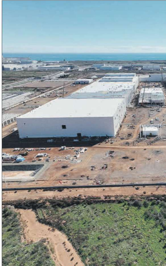
Sitio de construcción de la gigafactoría de PowerCo en Sagunto (Valencia). EE
