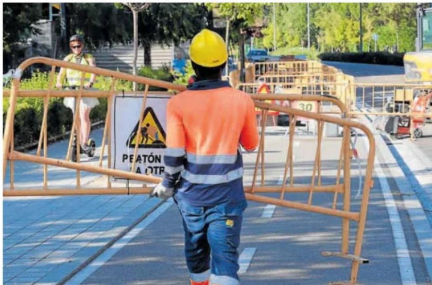
Un operario en el tramo de la avenida de Salamanca en obras, desde el cruce con la avenida de Gloria Fuertes hasta el de la avenida de Gijón. CARLOS ESPESO
