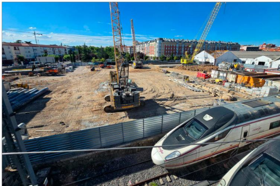
Estado de las obras donde se ubicará el futuro aparcamiento subterráneo de la nueva estación de trenes de Valladolid, ayer. PHOTOGENIC
