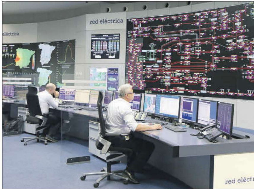
El centro de control de Red Eléctrica. EE
