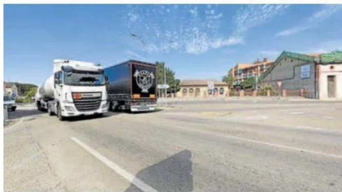
Cruce de la N-122 en Peñafiel con la VA-101 desde la que se incorporarán los vehículos que procedan de Valladolid por la A-11. A.G.E.
