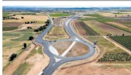
Enlace de Castrillo de la Vega, el último tramo de la A-11 inaugurado (2,4 kilómetros). MINISTERIO DE TRANSPORTES
