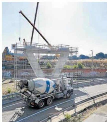
Las máquinas trabajan en el viaducto. c.ESPESO
