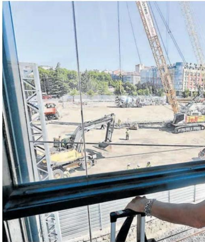
Una usuaria observa el desarrollo de las obras de la futura estación de Valladolid. CARLOS ESPESO
