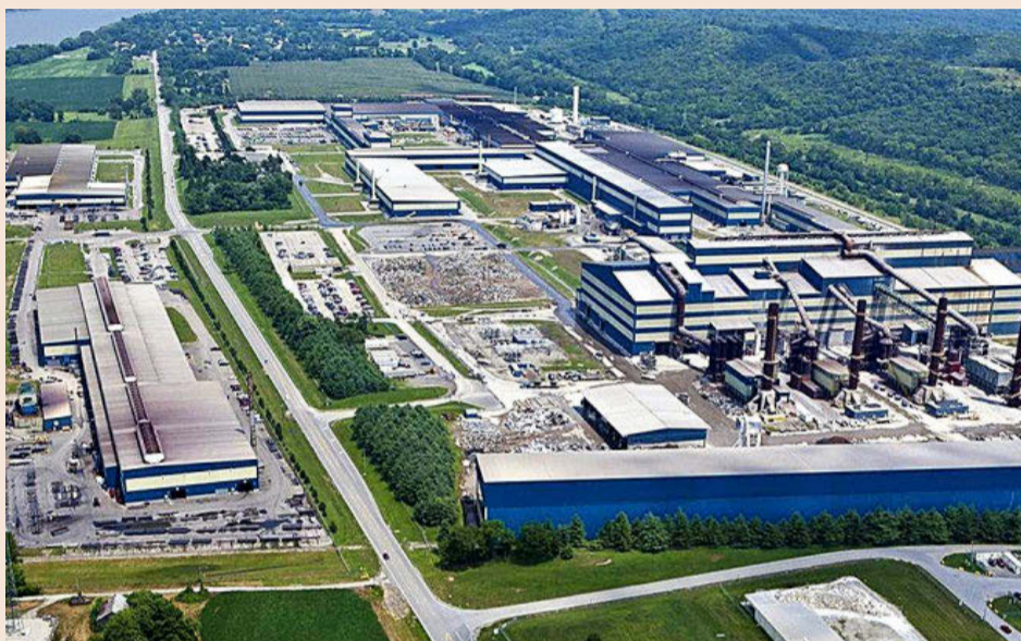
Instalaciones de NAS en Kentucky (Estados Unidos).
