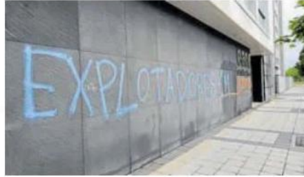
Estado de la fachada de la CEOE de Castilla y León en Valladolid. EL NORTE
