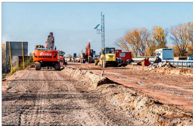
Movimiento de tierras con maquinaria pesada en una autovía en obras. PQS / COO
