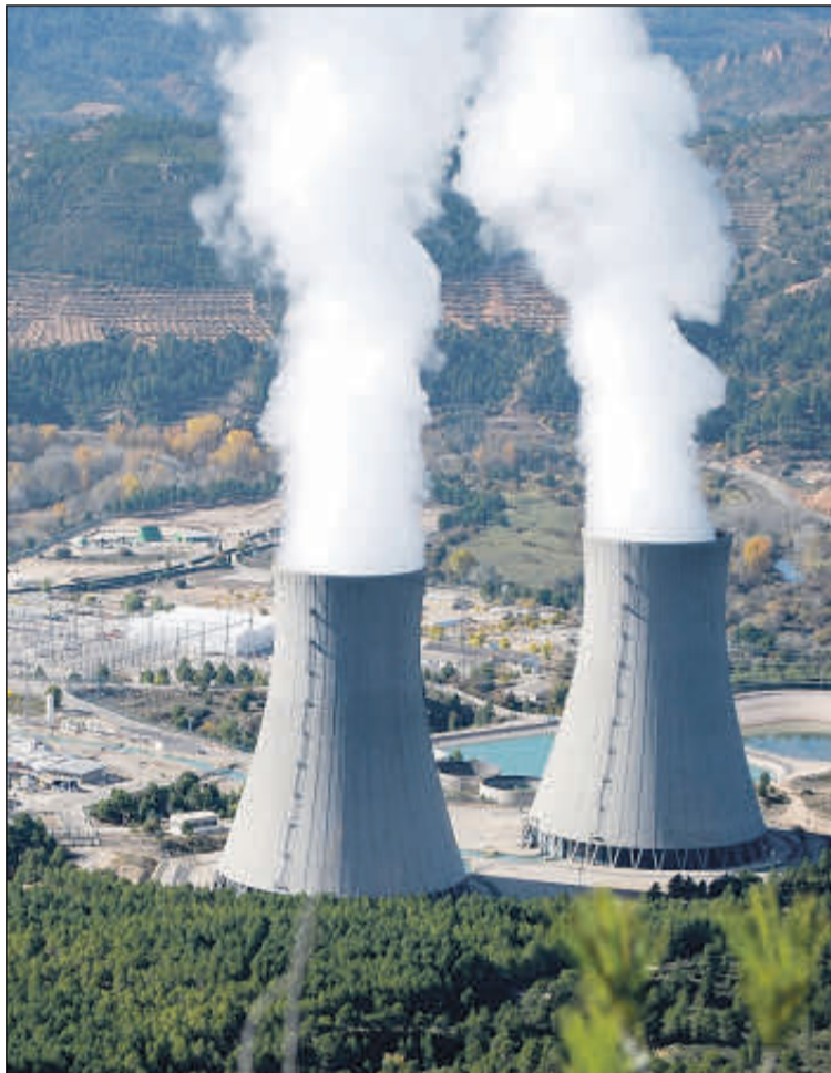
La central nuclear de Cofrentes. EE
