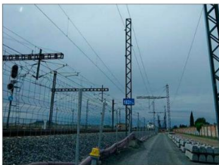
Trabajos previos de electrificación y suministros de material. E.M.
