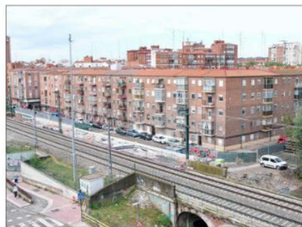
Obras de la tercera vía a la altura de Pilarica. PHOTOGENIC
