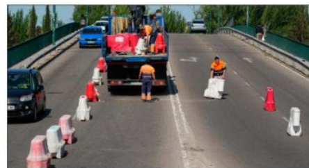
Trabajos en el asfalto del puente de Daniel del Olmo.
