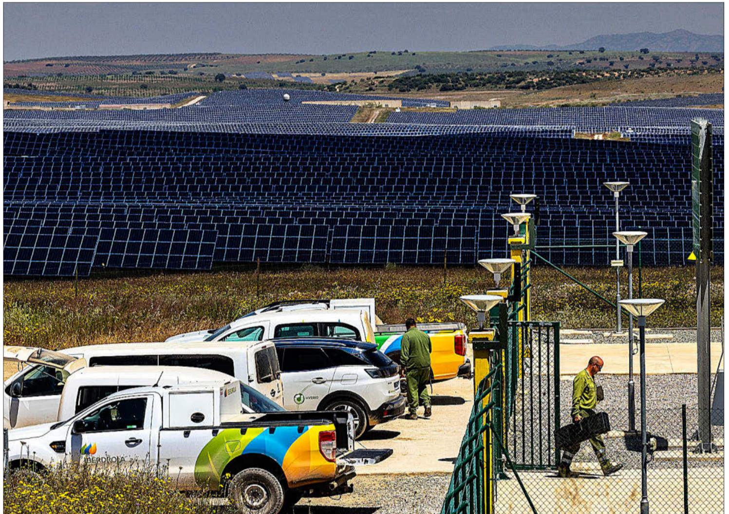
Varios trabajadores en una planta fotovoltaica de Iberdrola. CARLOS GARCÍA POZO
