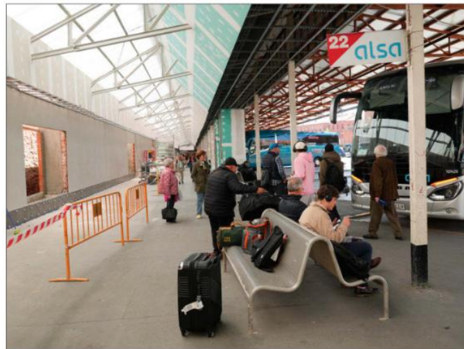
Zona de andenes, donde se aprecia el contraste entre la zona más avanzada y la pendiente. REP. GRÁFICO: JUAN GARCÍA
