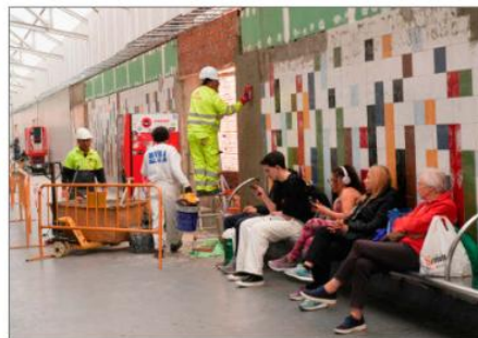
Avances en los trabajos de las paredes y los nuevos huecos de luz.
